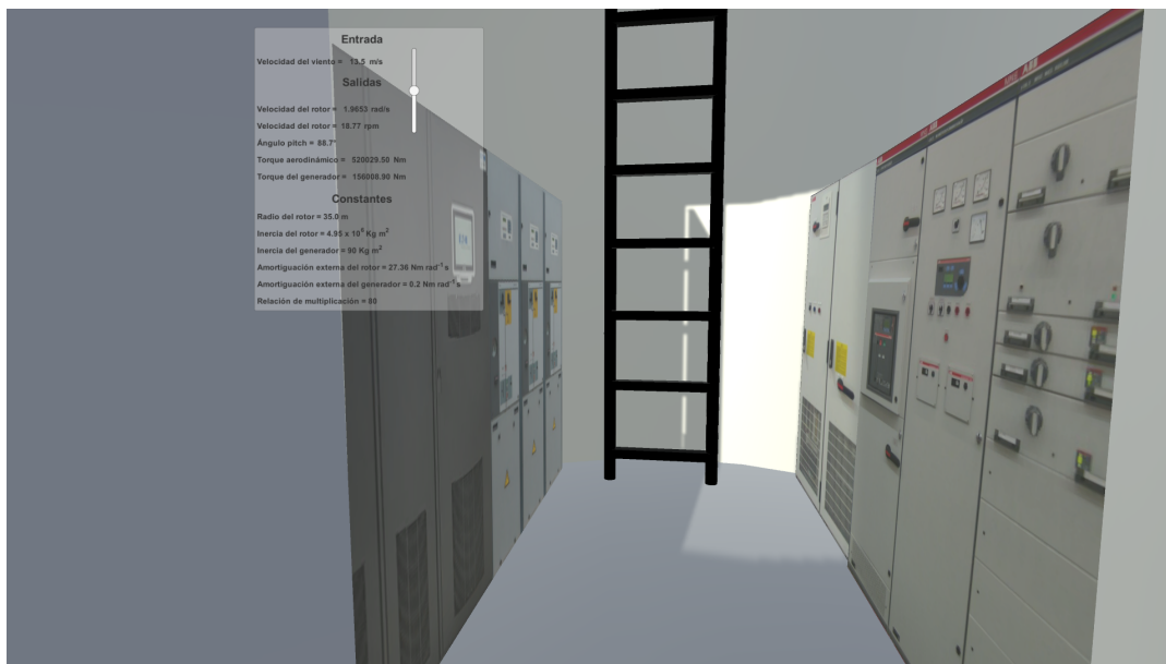
Figura 4.14. Vista al interior de la torre.
